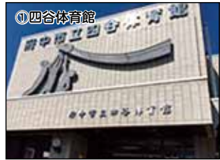
①四谷体育館 (共通) スタート&ゴール 市内一番西にある四谷体育館です。
